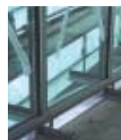
Glasschwerter zur Aussteifung der Konstruktion
