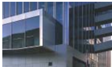
Die auskragende Glasrampe mit Glasfußboden gibt den Blick auf die Klosterstraße frei
