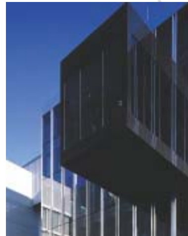
Die Skybox kragt aus dem Gebäudekörper aus
