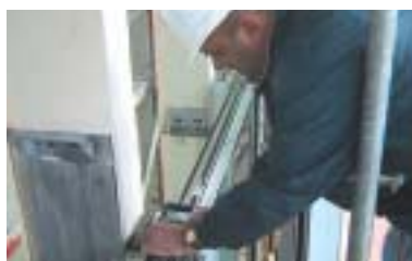
Abdichtung der horizontalen Kopplungsprofile der Kastenfassade
