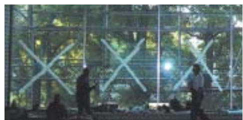
Montage der Glasfenster im Mehrzweckraum des ersten Obergeschosses
