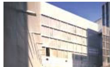
Der Paravant aus Stein und Beton ist als winkelförmiger Gebäudeteil angelegt und umschließt den Hauptbau
