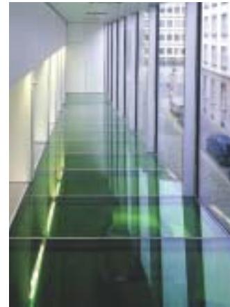
Die Glasrampe: durch grünes Glas blickt man fast 4 m in die Tiefe
