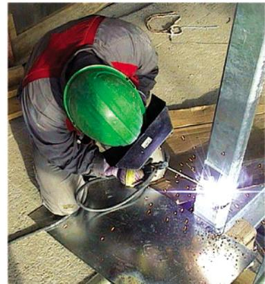
Schweißarbeiten an den Stahlpfosten im Bereich VIP
