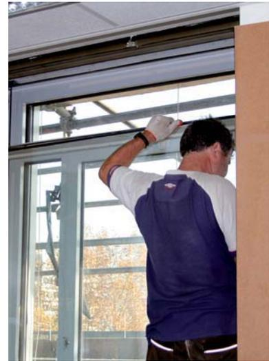
Die neuen Fensterelemente werden abgedichtet (Bild links), und die alten Fenster auf der Innenseite demontiert (Bild rechts).
