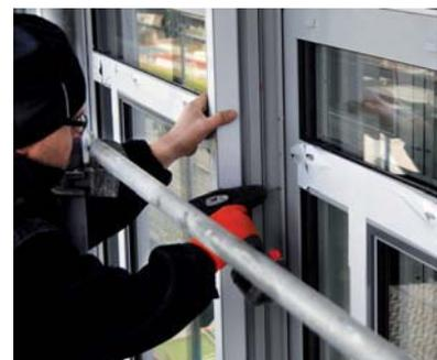
Bild oben: Wir rüsteten das Gebäude vor dem Montageprozess komplett ein. Bilder unten: Die Befestigungskonsolen werden am Baukörper befestigt; unsere Monteure bringen die neuen Fensterelemente auf den Innenseiten der Traglisene an.
