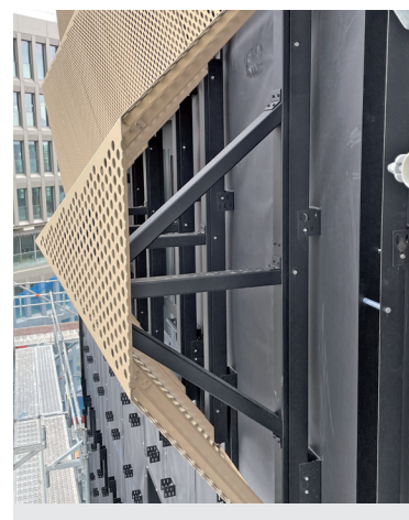
Gerüststellung für die partielle Montage
