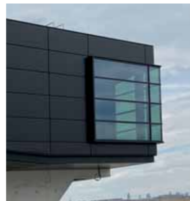
Brückenbauwerk der Pierstange H
