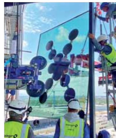
Montage der Scheiben am Tower
