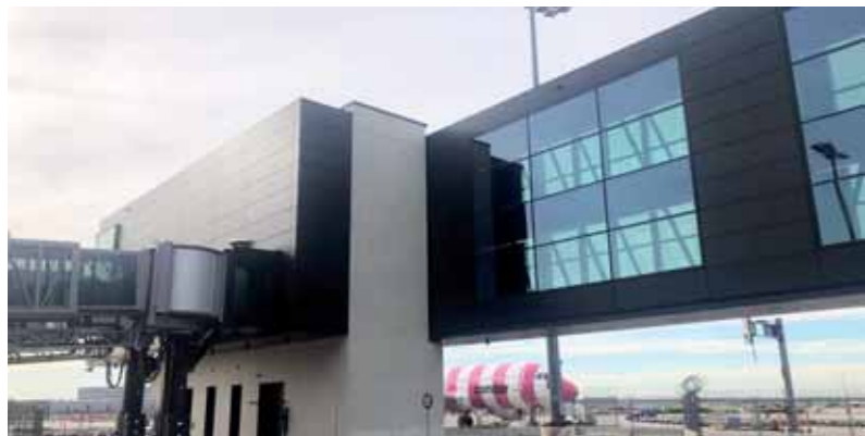
Brückenbauwerk der Pierstange J
