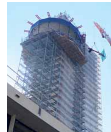
Das Kranen der Scheiben auf 70 Meter
