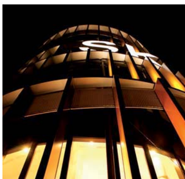
Die vertikalen Lamellen werden nachts durch energiesparende LEDs beleuchtet.
