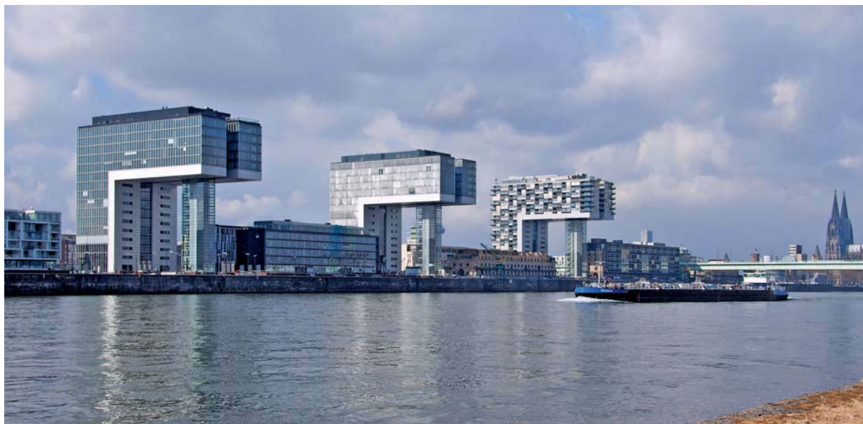
Tolles Trio: Die Gebäude erinnern an Kräne, die einst im Kölner Innenstadthafen die Flussschiffe beluden.
