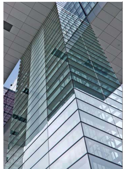
Der gläserne Aufzugsturm.
