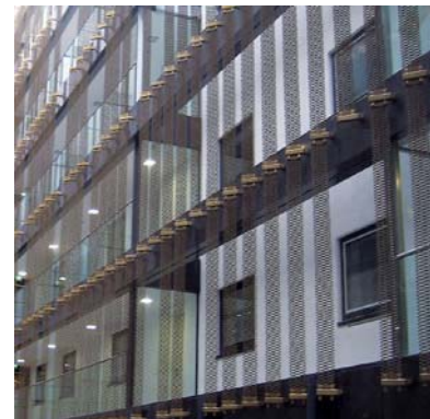
Atrium: Sichtschutz aus Streckmetall.
