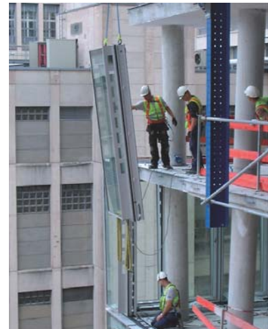
Unser Team bei der Montage der Fassadenelemente
