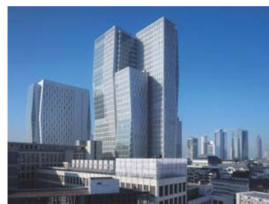
Bild oben: Das PalaisQuartier mitten in Frankfurt/Main; Bild unten: Büroturm mit Skyline im Hintergrund
