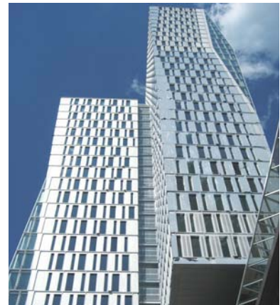
Der Büroturm mit den Doppelfassaden (links) und den einschaligen Fassaden (rechts) auf der Ost- und Westseite des Gebäudes
