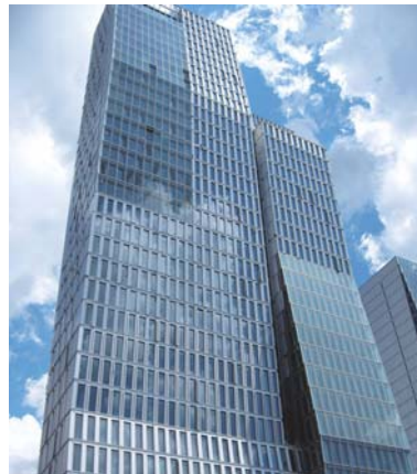
Der Büroturm mit den Doppelfassaden (links) und den einschaligen Fassaden (rechts) auf der Ost- und Westseite des Gebäudes
