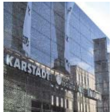
Die Werbeträger aus Edelstahl fügen sich harmonisch in die Fassade ein.
