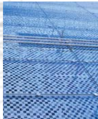
Der Rastersiebdruck ermöglichte die Ausführung von Fotos auf der Fassade.
