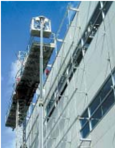
Montage der Stahlkonstruktion
