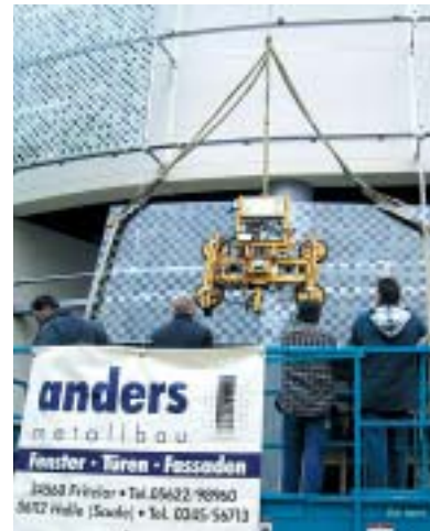
Einsetzen der Verglasung mit Sauganlage.
