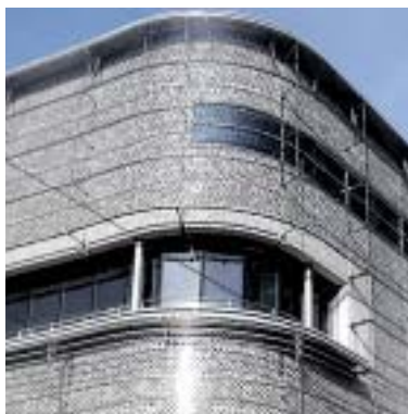
Gebogene Fassade an den Gebäudeecken
