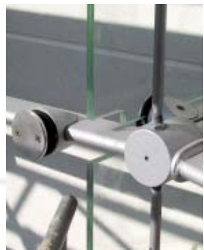
Detailansicht: Knoten, Glashalter, Riegel und Zugstäbe
